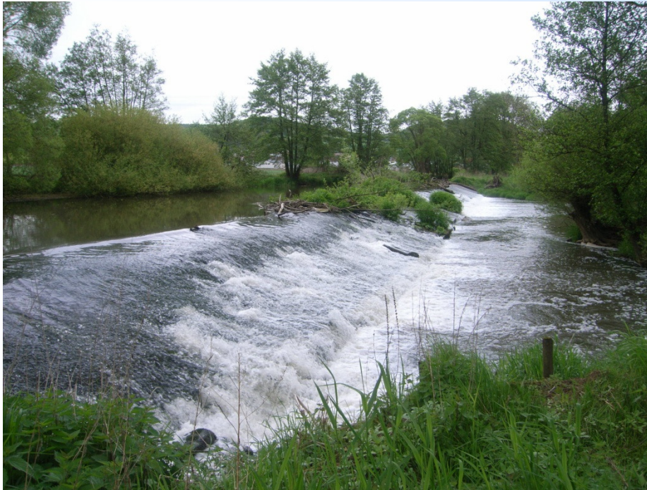
Wehr an der Schwalm bei Kerstenhausen derzeit nicht durchgängig
