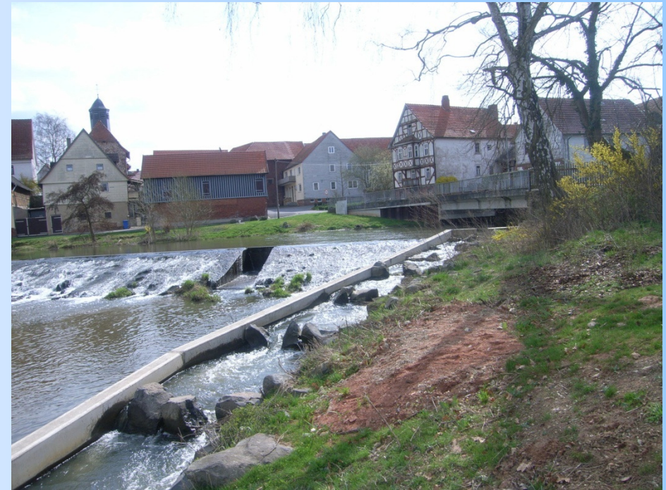
Fischaufstieg an der Schwalm in Rommershausen
